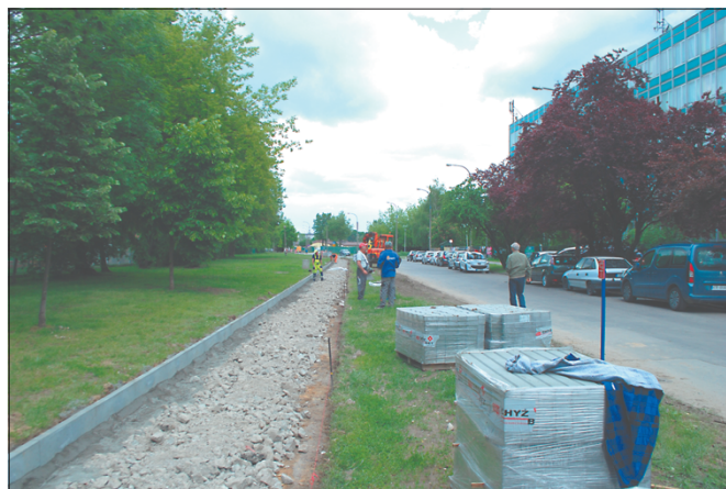
Trwa remont chodnika przy ul. Pokrzywki, łączącego osiedla Niepodległości i Alertyńskie. Fot. Zygmunt Bińczycki
