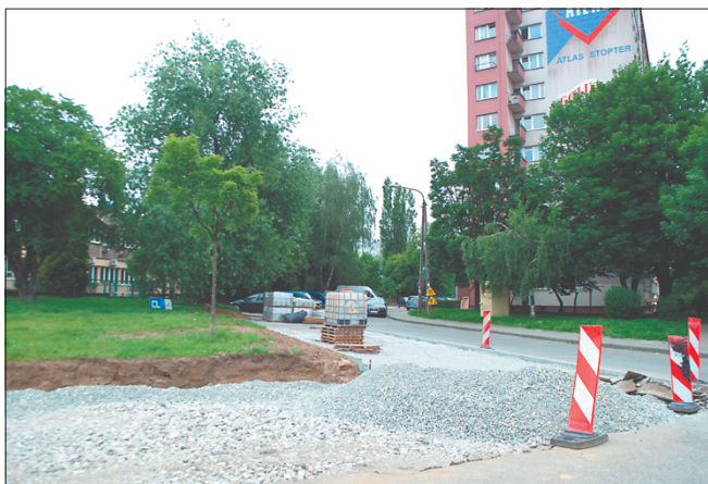
Remont chodnika i parkingu przy bloku nr 18 na os. Strusia. Fot. Zygmunt Bińczycki
